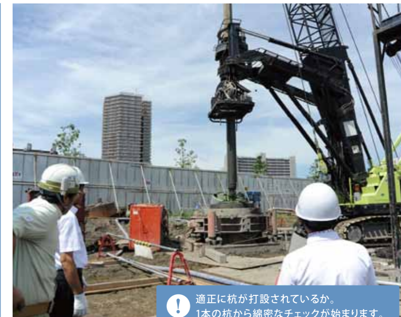
[試験杭の確認(場所打ち杭)]
