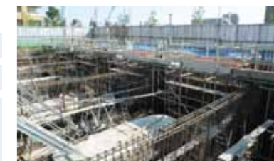
[基礎工事の風景]
