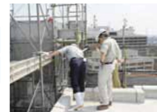
〔防水下地検査〕
