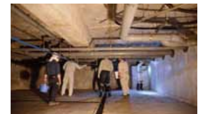
〔地下ピット内検査〕
