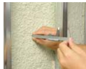
[断熱材の厚さ確認]
