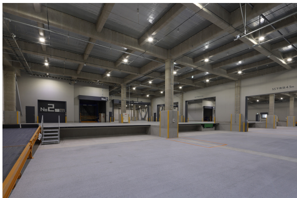
トラックバース・倉庫（1階）
