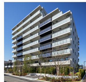
建物外観 （2024 年 1 月竣工時に撮影）
